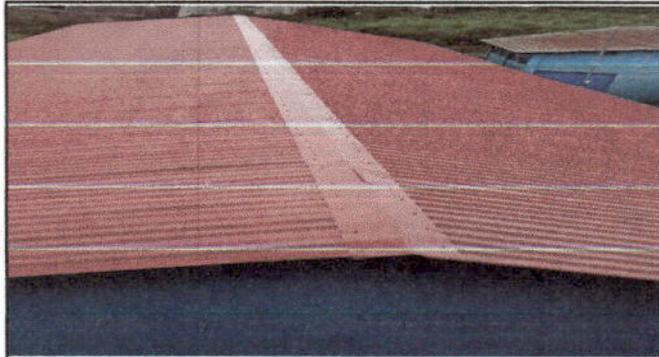
FOTO: 1 Lamina en buen estado.
